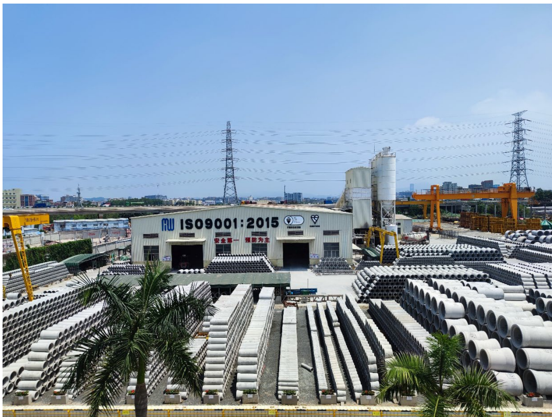
深圳沙井混凝土預製件廠
