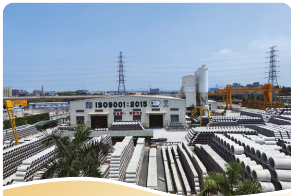
位於深圳沙井的混凝土預製件廠
